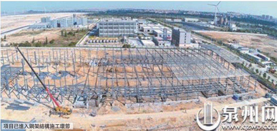
項目已進入鋼架結構施工環節
