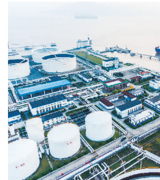
舟山国际油气储运基地。 资料图片
