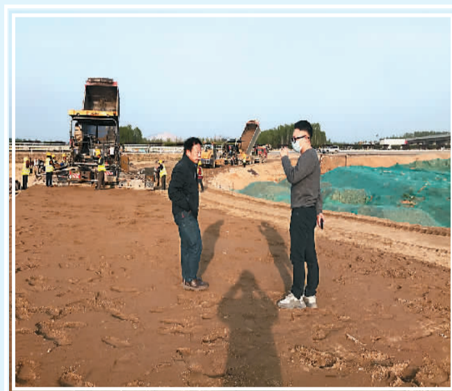
刘泽坤(右)在项目施工现场。(受访者供图)
