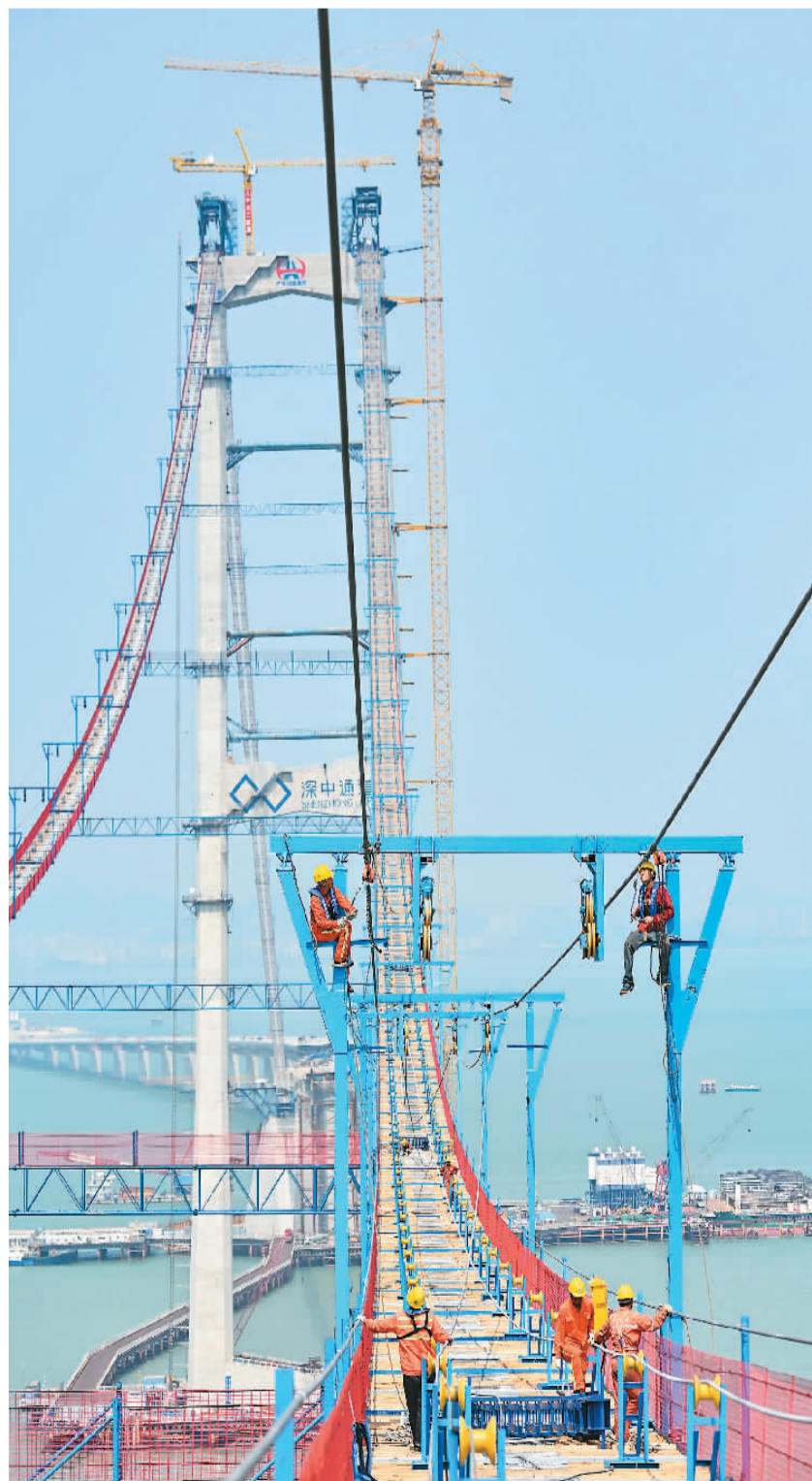
深中通道的伶仃洋大桥猫道近日实现全线贯通。该猫道最高点距离海面约270米、最低点距离海面约105米，是世界上海中最高、最深的猫道。深中通道是继港珠澳大桥之后，粤港澳大湾区又一个世界级跨海通道集群工程，全长24公里，预计2024年建成通车，届时深圳到中山的车程将从目前的2小时缩短至20分钟左右。
