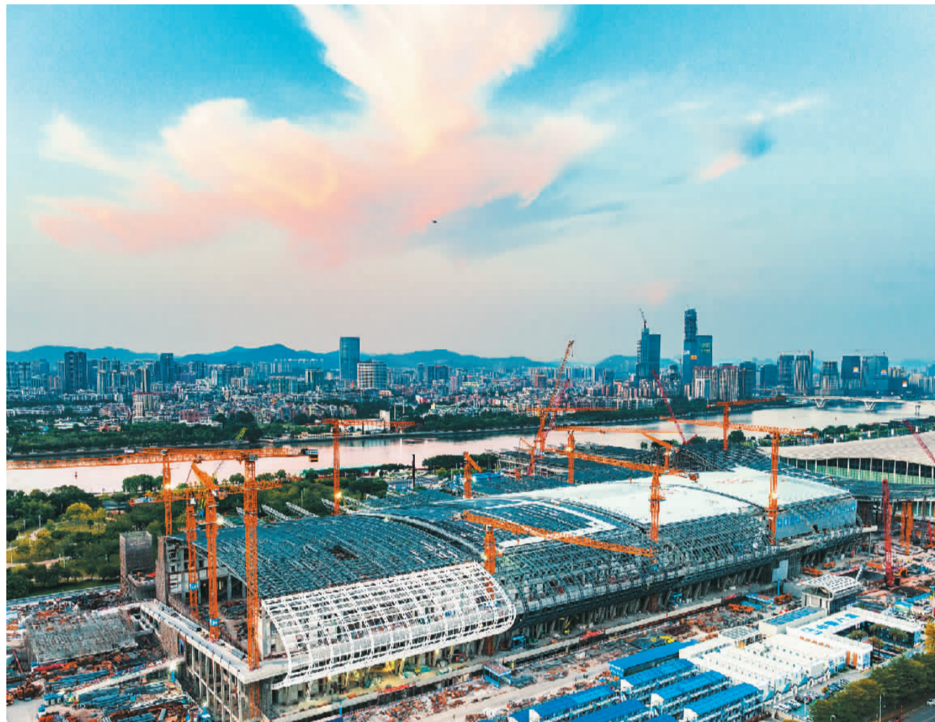
▲近日，位于广东省广州市海珠区的广交会展馆四期项目西地块钢结构工程全面封顶。该项目建成后新增展位6000多个。图为广交会展馆四期项目工程现场一派忙碌。
