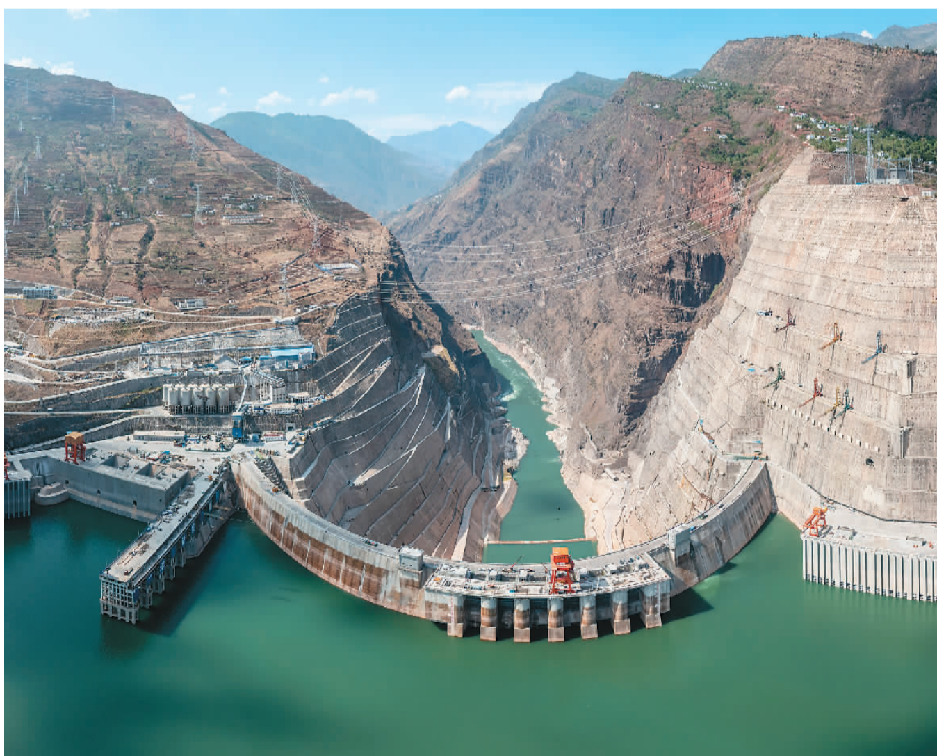
目前,白鹤滩水电站最后两台机组总装工作接近尾声,工程进入全面投产的冲刺阶段。白鹤滩水电站位于四川省宁南县和云南省巧家县交界的金沙江干流河段上,是实施“西电东送”的国家重大工程,总装机容量1600万千瓦。图为4月21日拍摄的白鹤滩水电站。
