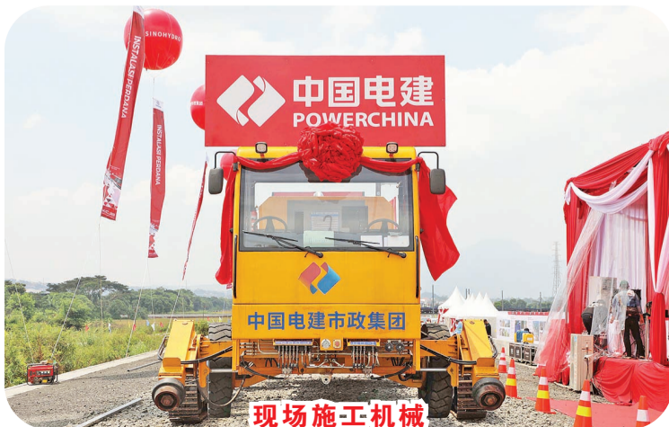
现场施工机械
