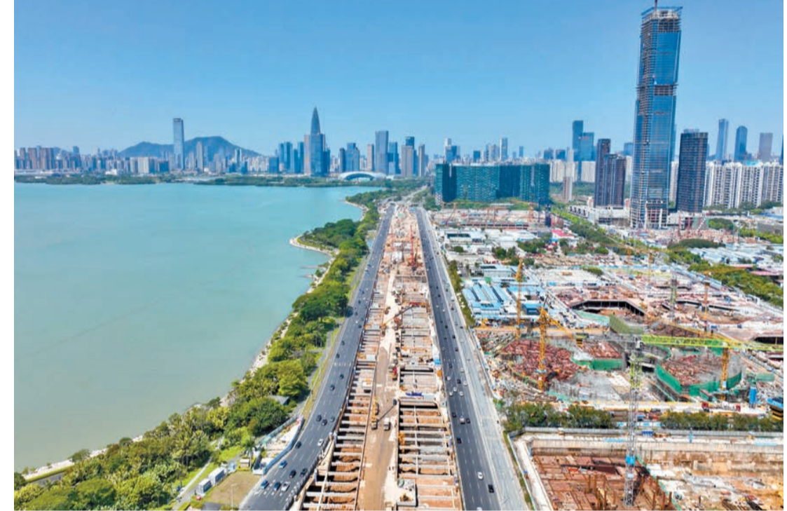
圖為深圳濱海大道交通綜合改造項目建設工地。該項目建成後，地面連接深圳灣公園，地下行車，形成「地面+地下」立體交通。
