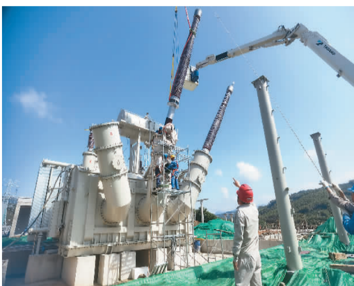
近日,在福建省漳州市云霄县马铺乡的闽粤电力联网工程现场,重达285吨的“巨无霸”换流变压器运抵就位,标志着该工程全面进入电气安装阶段。闽粤电力联网工程是国家“十四五”重点能源工程,去年4月开工,计划今年建成投产。图为闽粤电力联网工程施工现场。宋俊岭摄(人民视觉)
