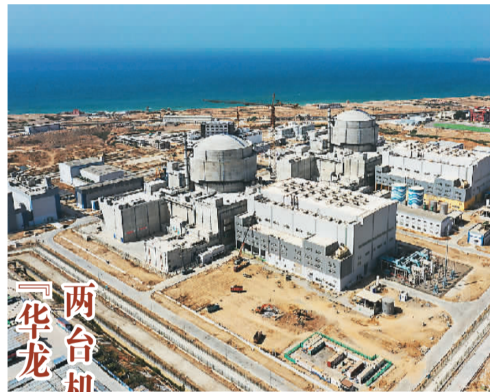
图为“华龙一号”海外首个工程——巴基斯坦卡拉奇核2、3号机组。王进杰摄
