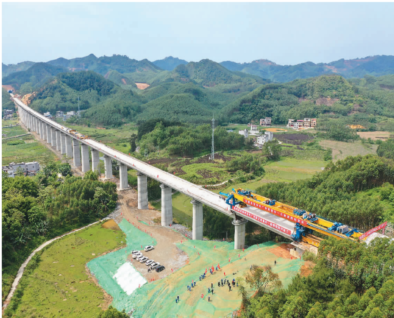
4月19日,位于广西壮族自治区南宁市马山县的贵南高铁位升双线特大桥最后一榀箱梁架设施工顺利完成,标志着贵南高铁广西段正线桥梁工程全面竣工。图为贵南高铁位升双线特大桥建设现场。新华社记者 陆波岸摄
