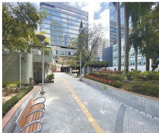
尖沙咀雨水排放系統改善工程，包括在市政局百週年紀念花園建造一所地下雨水泵房。
