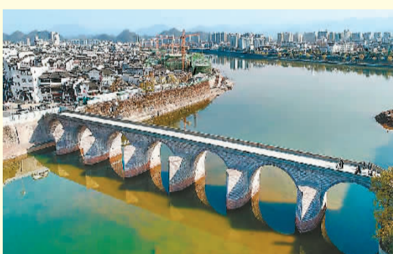
修缮后的屯溪镇海桥。潘成 吴江海摄
