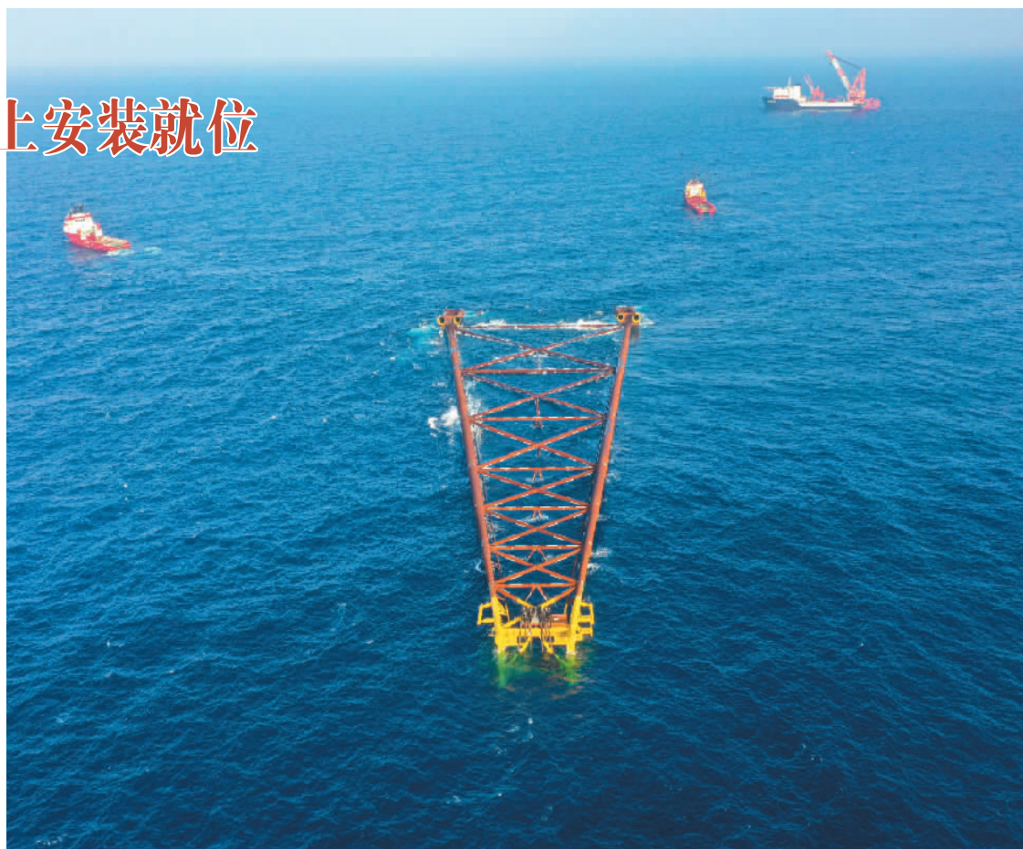
图为“海基一号”在珠江口盆地海域成功滑移下水并精准就位。李浩玮摄
