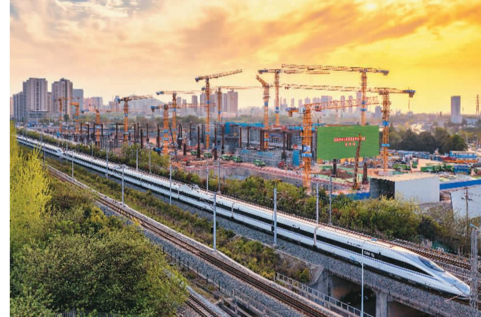
近日，安徽合肥西站站房主体结构工程施工如火如荼，项目综合开发及东广场项目超大深基坑支护工程也在同步施工。据悉，合肥西站站场规模设计为8台18线，高架站房面积8万平方米，建成后将与合肥站、合肥南站共同构成合肥铁路枢纽“三足鼎立”的客运系统布局。
