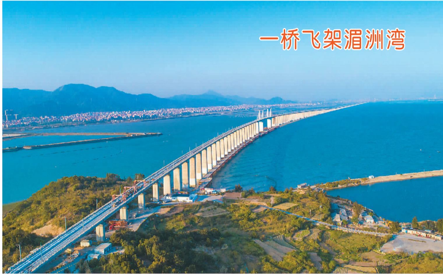
4月9日,中铁十一局承建的新建福州至厦门高速铁路(简称福厦高铁)湄洲湾跨海大桥无砟轨道施工完成,为后续铺轨贯通和通车运营创造了有利条件。新建福厦高铁湄洲湾跨海大桥位于莆田市及泉州市境
