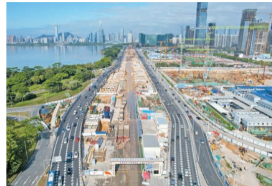
深圳重大交通工程項目施工現場。
