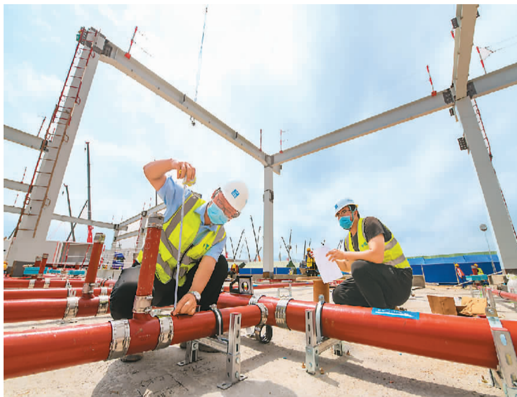
图为3月21日,建设者在中央援港应急医院项目一期施工现场忙碌。新华社记者 梁旭摄
