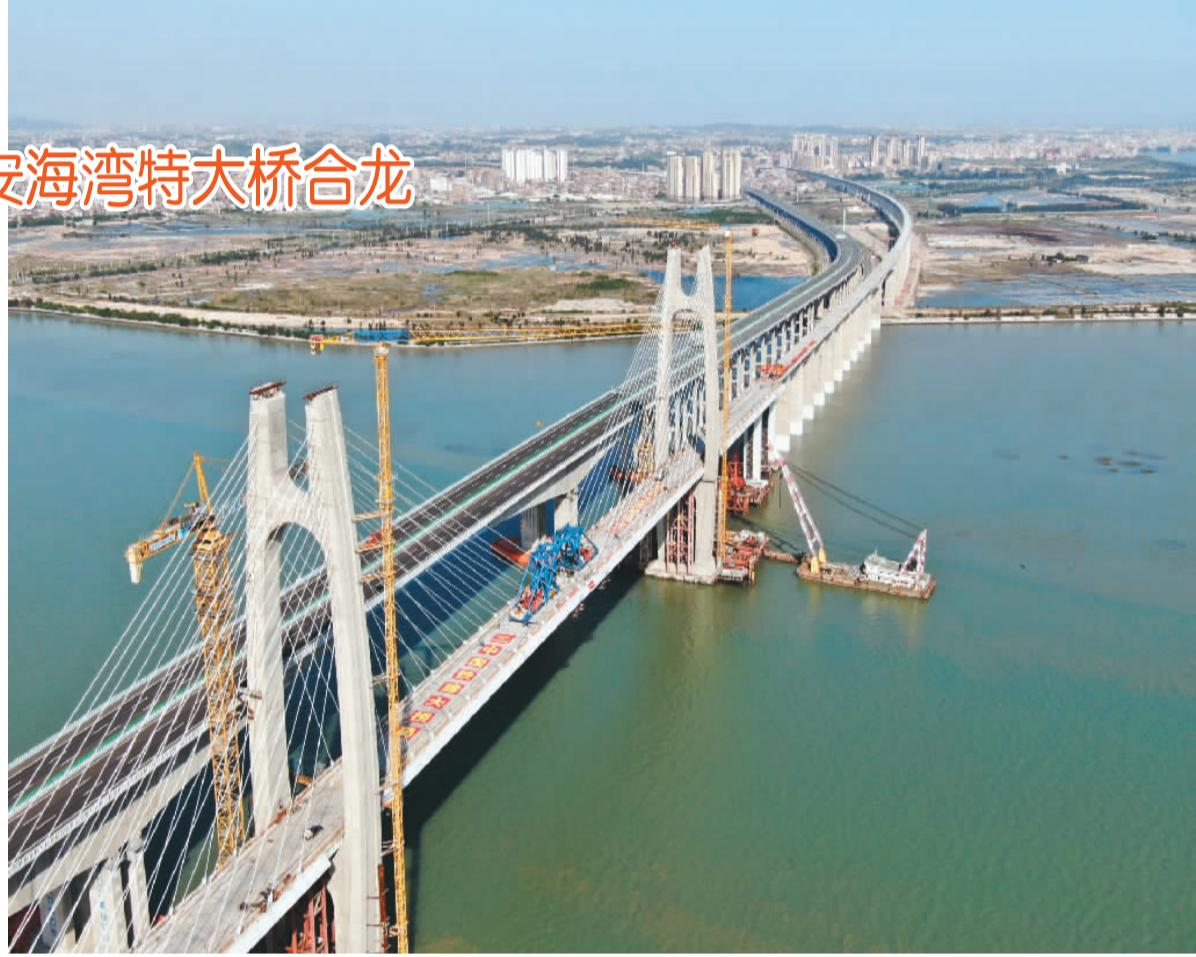
4月6日，新建福厦铁路安海湾特大桥最后一节钢箱吊装成功，大桥合龙。大桥无砟轨道铺设施工将随后全面展开，乘坐350公里时速高铁过海不减速的愿望即将实现。图为福厦高铁安海湾特大桥。
