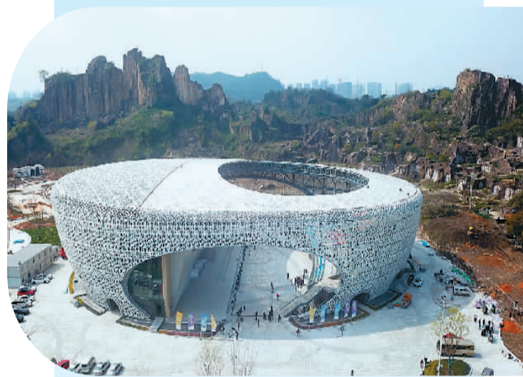
绍兴柯桥羊山攀岩中心
