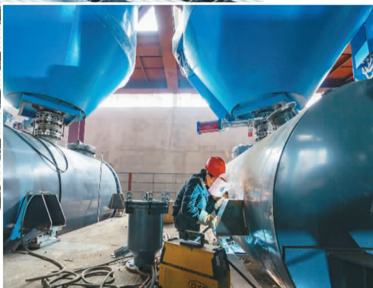
4月1日,工人在工地忙着焊接反应釜支架。
