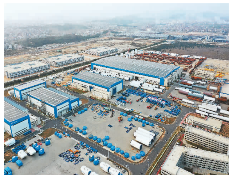
图为福建三峡海上风电国际产业园一角。新华社记者 林善传摄
