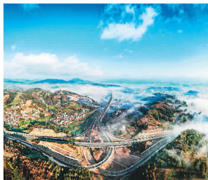
云南省楚雄（广通）至大理高速公路扩容工程（即新楚大高速公路）3月31日正式通车并联网收费。通车后，楚雄至大理仅需1.5小时，昆明到大理约需2.5小时。 图为近日拍摄的新楚大高速公路。 赵诚春摄（人民视觉）
