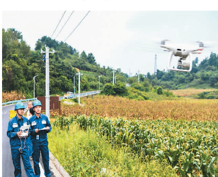
眼下正值春耕春管关键时期，南方电网贵阳供电局派出上百名巡检人员，采用无人机重点对辖区内涉农电力线路开展检查，及时处理设备隐患，确保农户春耕生产用电安全可靠。图为工作人员在巡检。 杨志坚摄（人民视觉）
