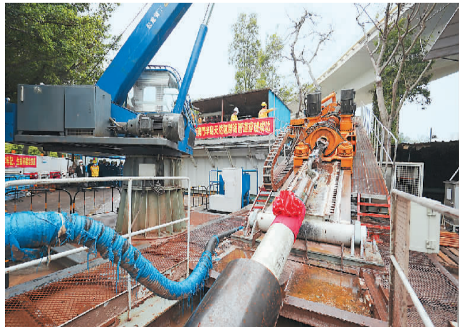
图为氹仔至澳门半岛天然气过海管道施工现场。梁建华摄(新华社发)
