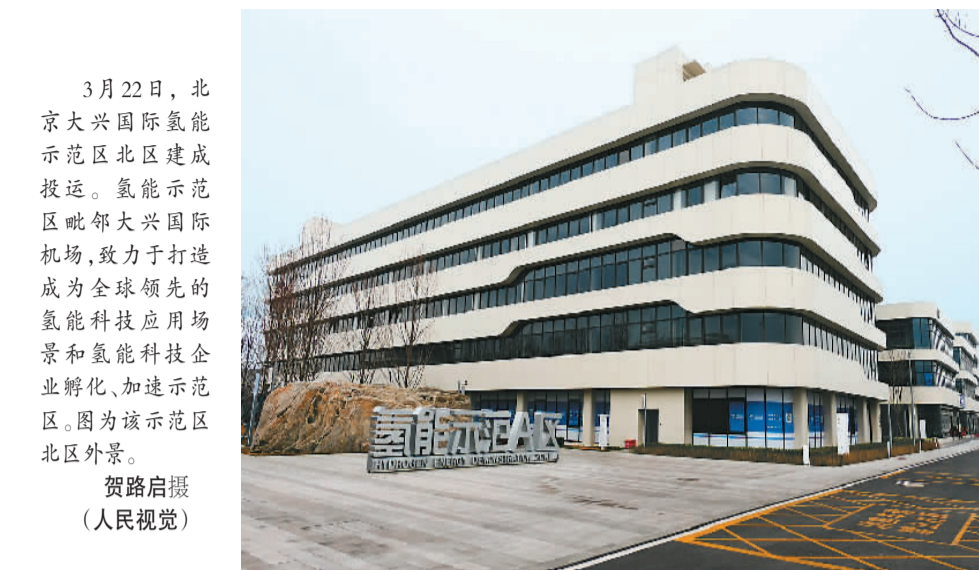
3月22日，北京大兴国际氢能示范区北区建成投运。氢能示范区毗邻大兴国际机场，致力于打造成为全球领先的氢能科技应用场景和氢能科技企业孵化、加速示范区。图为该示范区北区外景。
