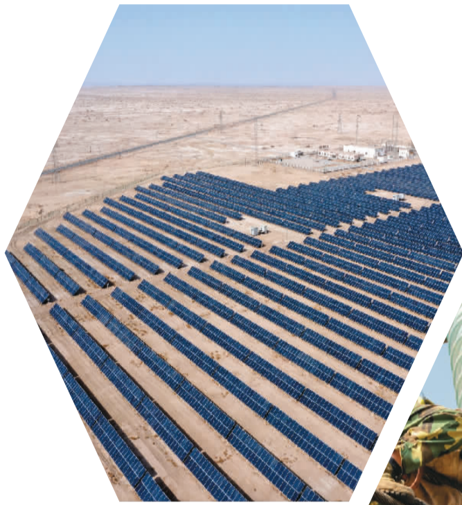
▲发展光伏发电对促进“双碳”目标实现具有重要意义。图为3月5日，位于新疆巴音郭楞蒙古自治州尉犁县的一处光伏电站正在运行中。
