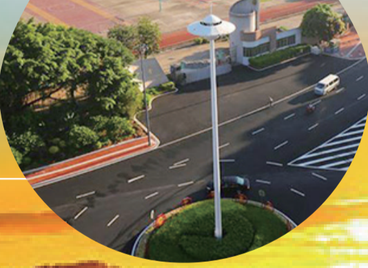
《美》張錦宣 攝于惠安縣城區市政道路瀝青化改造提升工程
