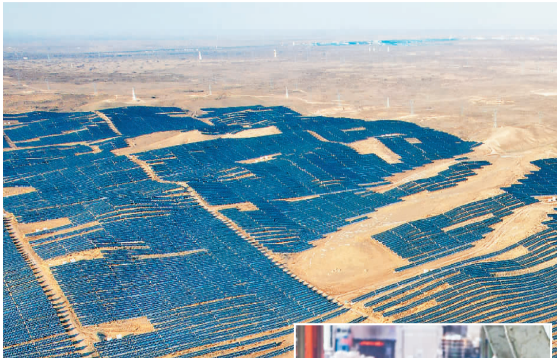
▲2月21日，国家能源集团宁夏电力公司200万千瓦光伏项目正在如火如荼建设中，建成后将成为“西电东送”重要通道的绿色电源点。 新华社记者 王 鹏 摄
