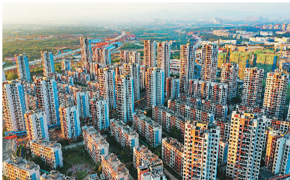
江西省赣州市蓉江新区的阳光·金色春城公共租赁住房小区是该市最大的保障性住房小区。近年来,赣州市不断扩大公租房保障覆盖面,重点解决城镇中低收入家庭、新就业职工、稳定就业的外来务工人员住房困难,建成近16万套保障性住房,让50多万困难群众安居乐业。图为该小区俯瞰图。朱海鹏摄(人民视觉)
