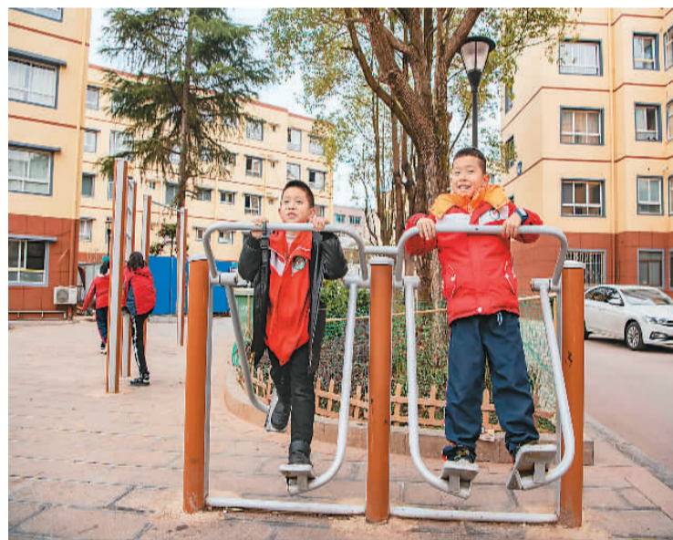
近年来,贵州省黔西市将建筑物立面改造、道路“白改黑”以及燃气管道、电力及弱电线路等改善提升项目列入民生服务清单,让老旧小区旧貌换新颜,改善了居民居住条件和生活品质。图为黔西市水西街道水西社区安居园小区,环境焕然一新。罗兴祥摄(人民视觉)
