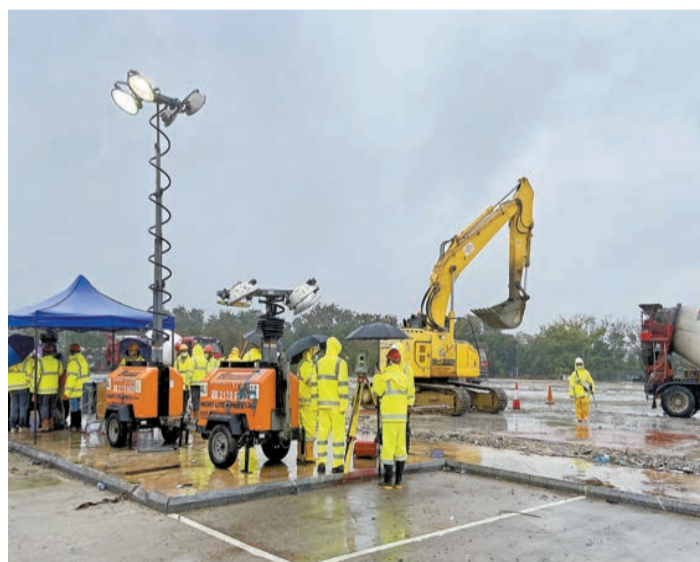
昨日，新田購物城臨時性社區隔離治療設施開工建設。
