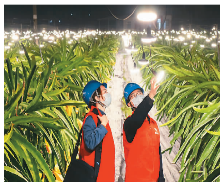
入春以来，广东惠州供电局根据春耕生产用电特点，主动当好农民的“电管家”，开展春耕备耕特巡特维和专项用电检查行动，确保春耕生产“电力十足”。图为2月21日，在惠州惠东火龙果种植基地，南方电网广东惠州供电局工作人员在进行用电检查和夜巡测温。 陈奕莹摄（人民视觉）
