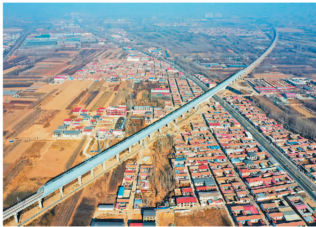
京雄城际铁路河北霸州段的全封闭声屏障。
