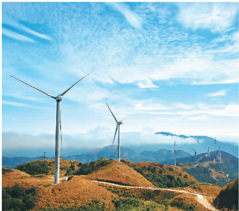
近年来，广西玉林市因地制宜发展清洁能源产业，以清洁能源助力经济社会绿色低碳转型。近日，南方电网广西玉林供电局顺利完成玉林市第十四座风电场一百一十千伏昌鸿风电场并网送电。项目并网后，每年可输送二百七十千瓦时绿色清洁能源。图为矗立在高山上的昌鸿风电场发电机组。 余晨摄（人民视觉）
