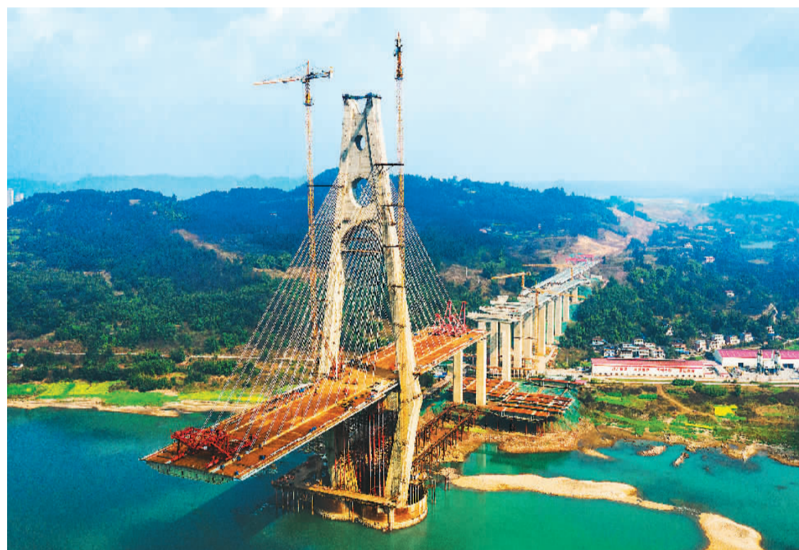
春节过后,四川宜宾临港公铁两用长江大桥加快建设进度。大桥全长1742.1米,主桥长1073米,桥面宽63.9米,主跨522米,是时速350公里自宜高铁的控制性工程。
