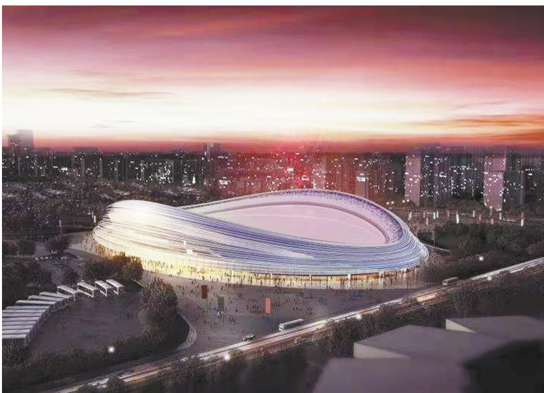
國家速滑館的22條“冰絲帶”是由中山企業研發製造的1.2萬塊光伏發電玻璃拼接而成。 明陽集團供圖
