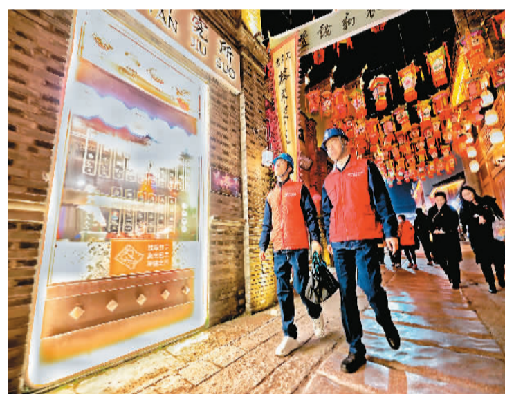
▲ 春节假日期间，安徽省芜湖市供电公司为保障芜湖市西河古镇老街用电安全，员工值守岗位、巡查用电设施。 赵晶晶 何煜摄影报道
