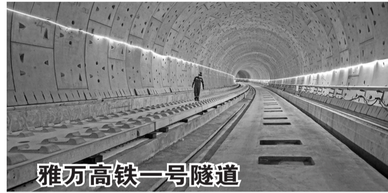
雅万高铁一号隧道
