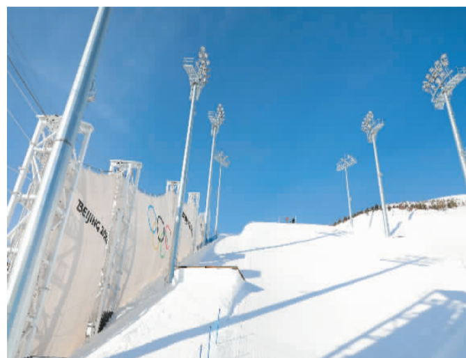
日前, 防风墙在北京冬奥会张家口赛区云顶滑雪公园亮相。防风墙的建立可以有效地减小大风对运动员的干扰, 保证赛事正常运行。图为1月19日拍摄的云顶滑雪公园防风墙。 武殿森摄(新华社)
