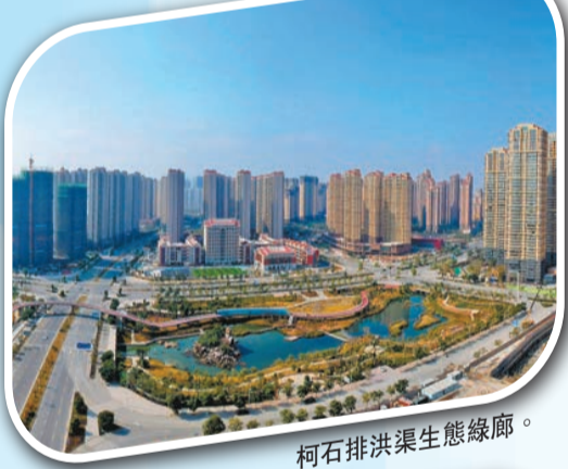
北峰—豐州滯洪排澇系統一期潘山泵站。
