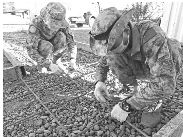
图为2021年11月3日,中国第九批赴马里维和工兵分队梅纳卡分队官兵对焊接后的地基钢筋进行固定。新华社发
