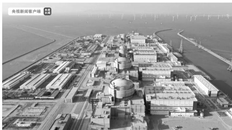
福清核电工程现场
