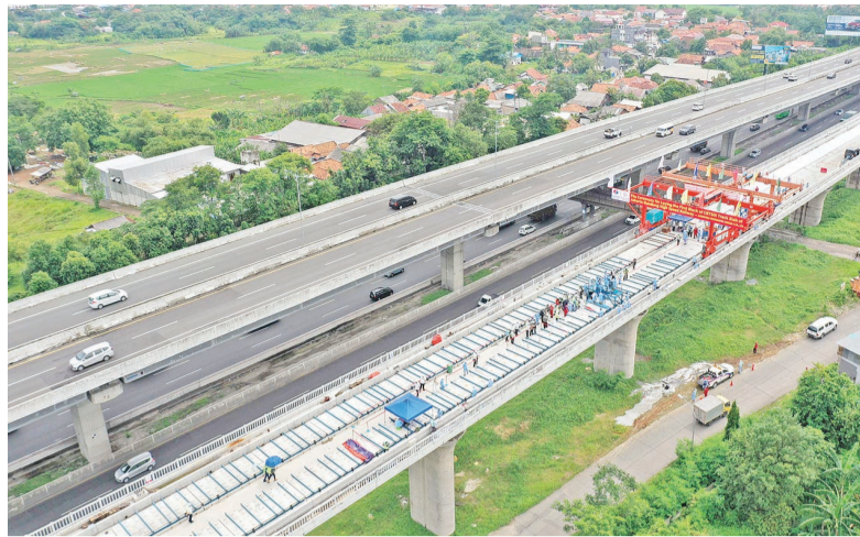
无砟轨道铺设施工现场
