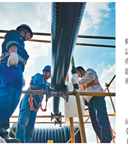
●世界首條35千伏公里級超導電纜試拉試驗現場。國家電網圖
