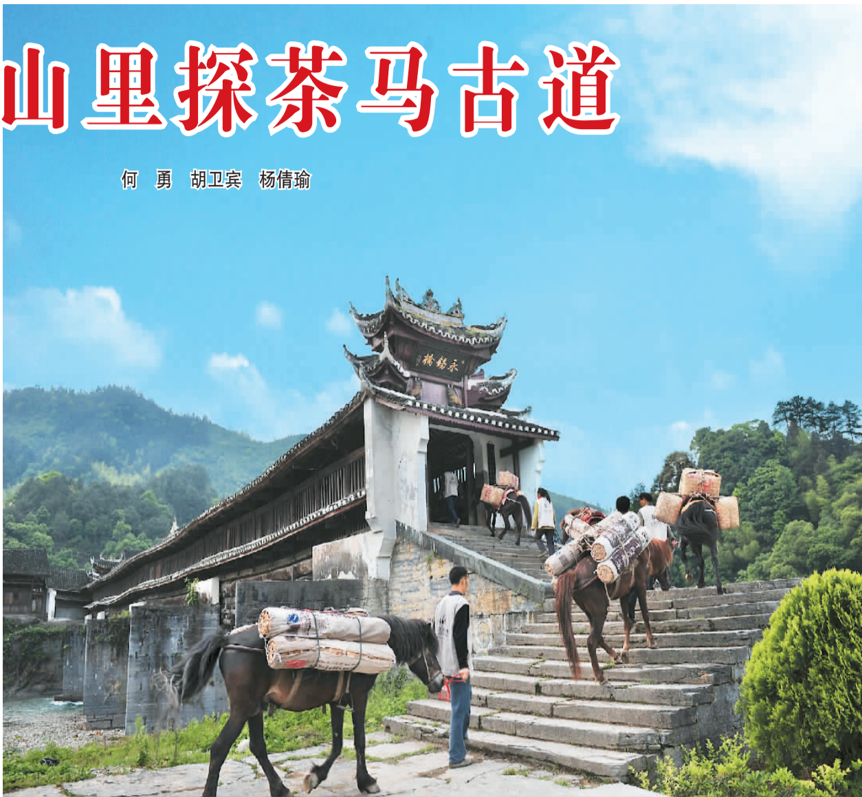
安化茶马古道—永锡桥。
