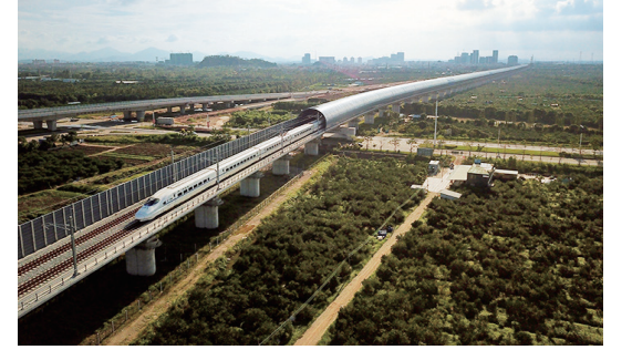
深茂鐵路工程建成全球首例高速鐵路拱形全封閉聲屏障，為護鳥按下“靜音鍵”。郭永樂攝。
