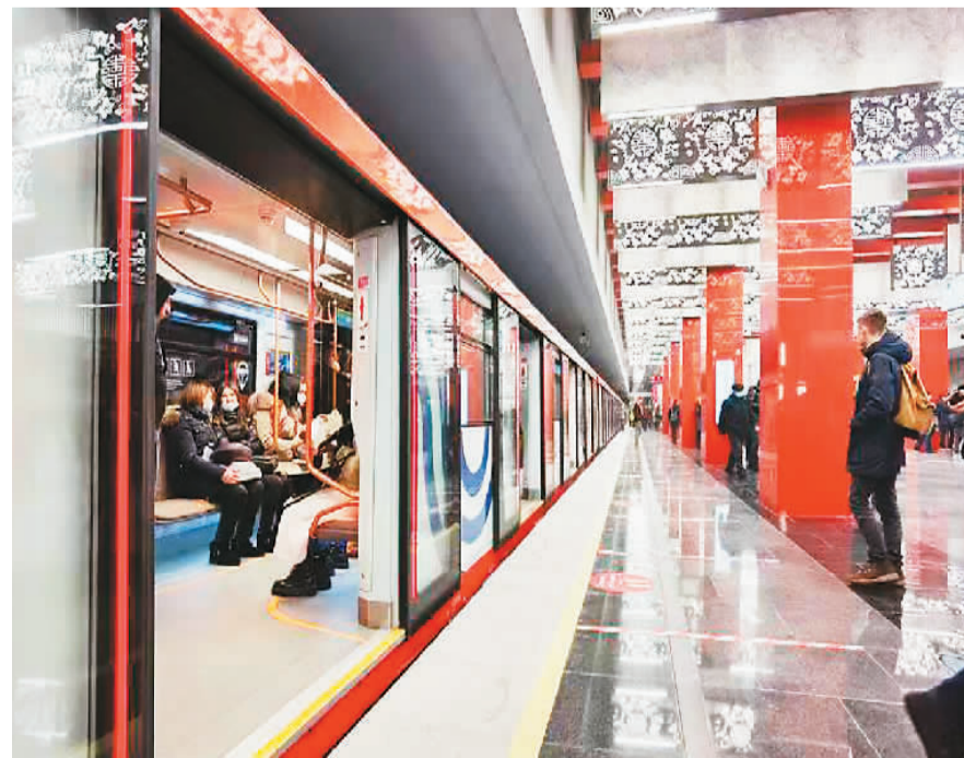
图为莫斯科地铁第三换乘环线西南段项目。
