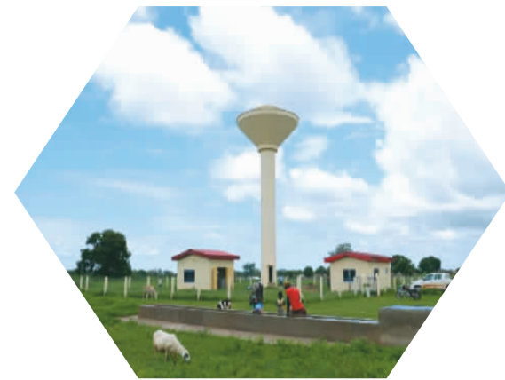
▲ 乡村打井工程的完整水井配套项目。中地海外集团有限公司公众号供图
