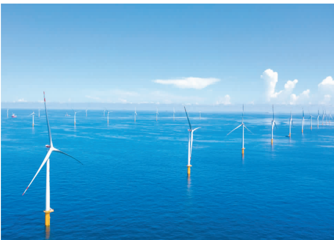
广东省充分发挥海岸线长、海域辽阔的优势，大力发展可再生能源，实现经济可持续发展，助力碳达峰、碳中和目标实现。截至11月30日，南方电网在广东海上风电并网接入总容量累计超过400万千瓦。图为广东揭阳神泉—315兆瓦海上风电项目，蓝天白云与湛蓝海水把风电场衬托得十分美丽。方荣滨摄（人民视觉）
