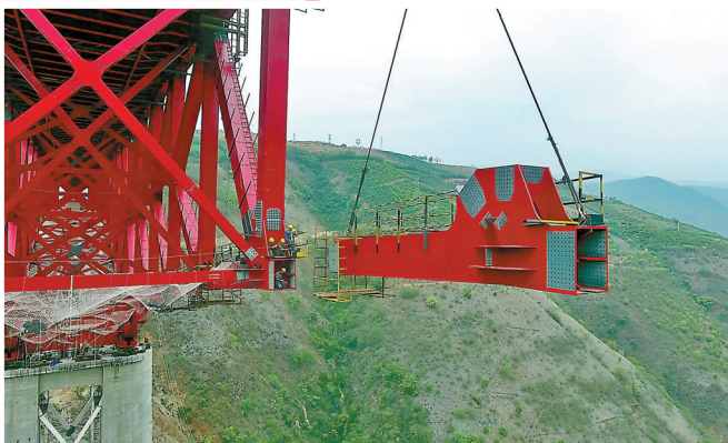
● 大橋吊裝作業。中鐵昆明局供圖
